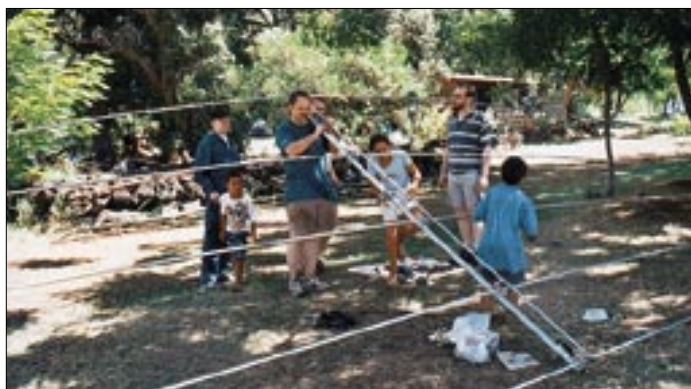
Einheimische Helfer bei der Montage der LP5 für 10 bis 20 m. In der Bildmitte Dietmar, DL3DXX, dahinter Manfred, DK1BT, rechts Norbert, DL9NEI
