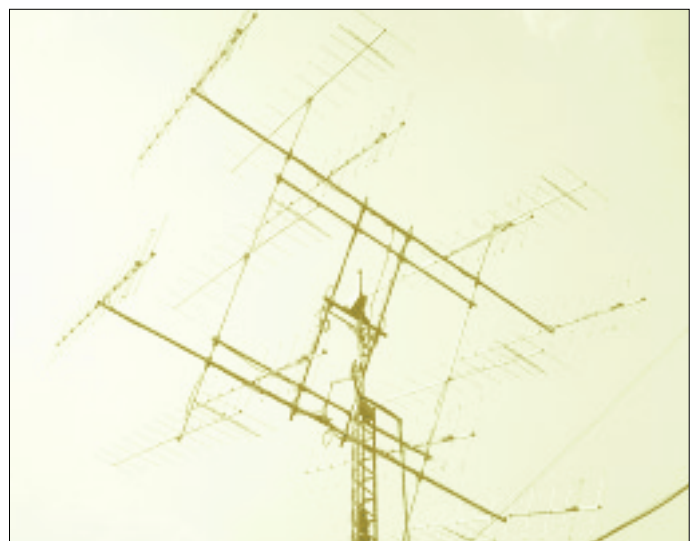
Bild 12: Zwei ineinander verschachtelte Antennensysteme, bestehend aus sechs Horizontal- und acht Vertikalyagis, bei JN1CSO
